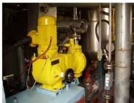
石化：高壓聚乙烯裝置 過氧化物引發劑添加
